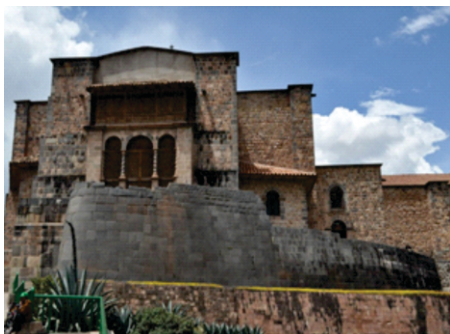
Fig. 6 Vista del muro curvo inca con el Tambor Solar liberado del relleno que sostenía el balcón de la iglesia. El abside del altar mayor fue retirado hacia atrás. Se puede observar, en la parte superior, los arcos de medio punto con columnas balastradas.
